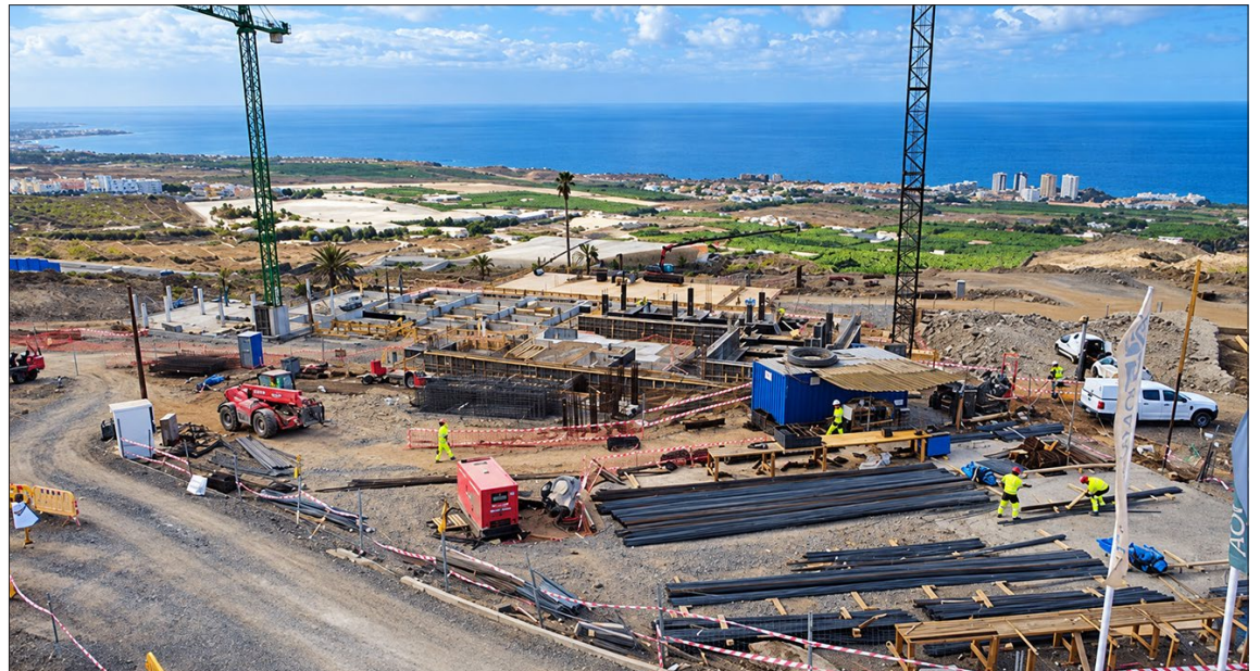
Las obras de Aquarelle están ya avanzadas y la entrega de las viviendas está prevista para el mes de noviembre del año próximo.
