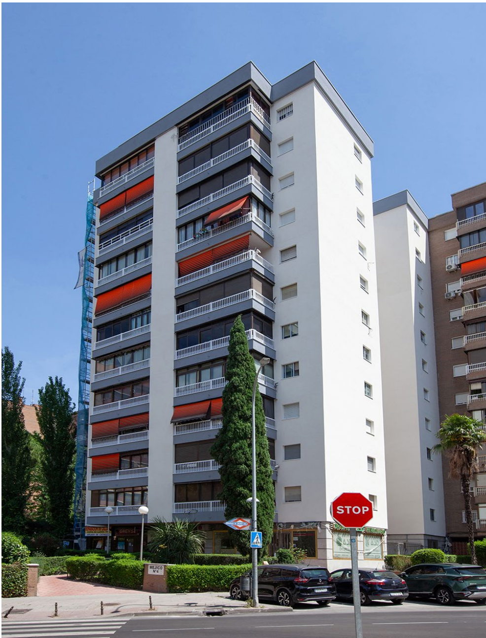
Rehabilitación energética mediante SATE en la calle México 4, Coslada, una actuación de 543.032 euros con una subvención Next Generation concedida del 80 %.
