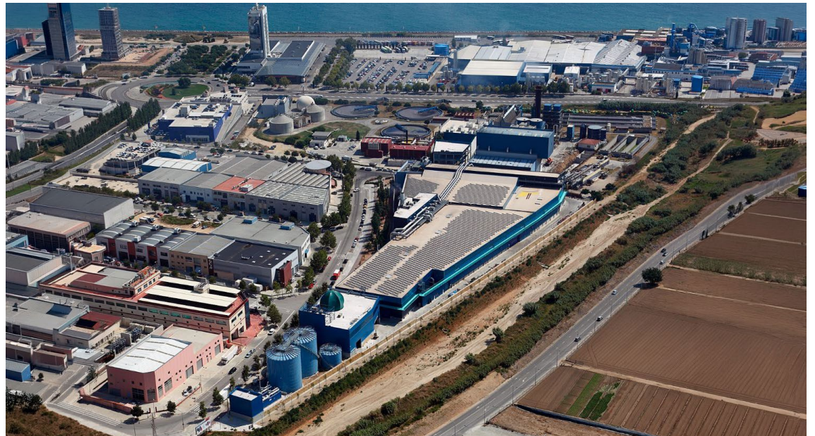
Vista aérea del Centro Integral de Valorización de Residuos del Maresme (Mataró)
