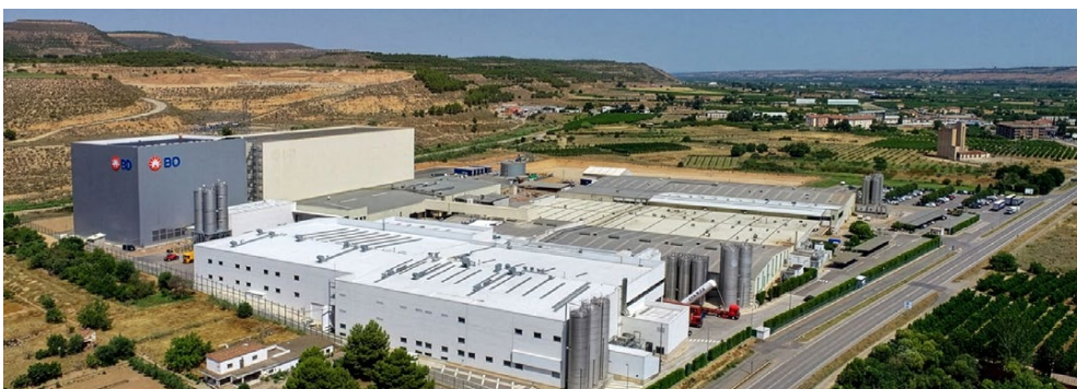
Vista aérea de la planta de BD en Fraga.
