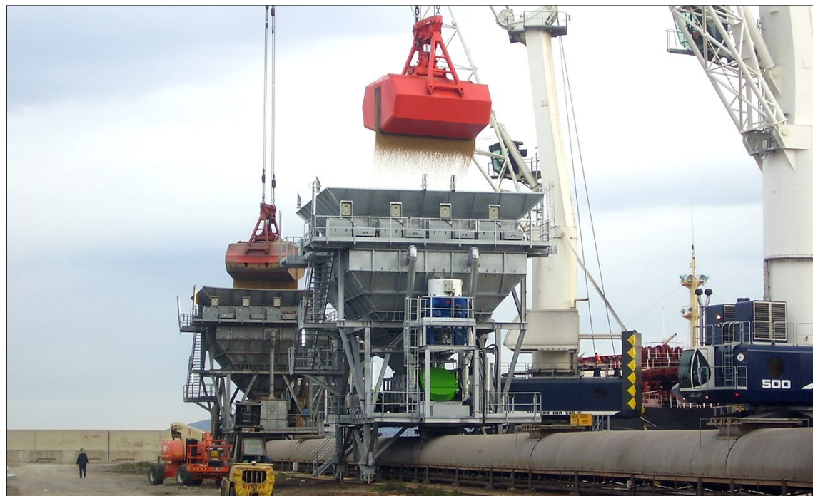
Instalación de descarga de graneles en el Puerto de Bilbao
