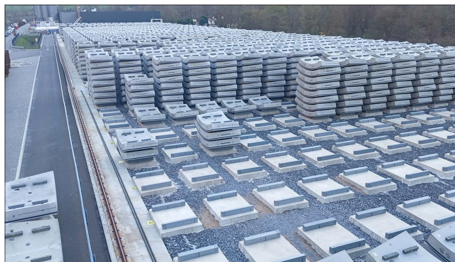
Obra túnel ferroviario TELT Lyon-Turin, ejecutada por Campenon Bernard, con bloques para dovelas hanit®
