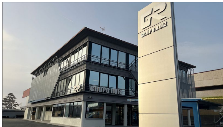
Edificio de oficinas para Grupo Ruiz
