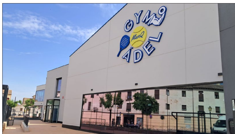
Centro deportivo Pádel
