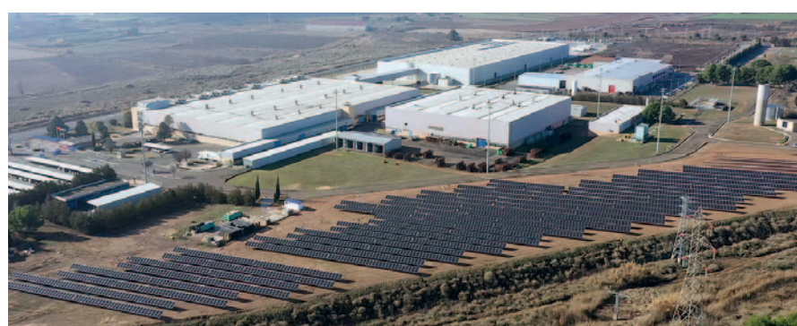
Autoconsumo fotovoltaico de 2 MWn, realizado por RÍOS RENOVABLES, en las instalaciones de SKF Española ubicadas en Tudela (Navarra).
