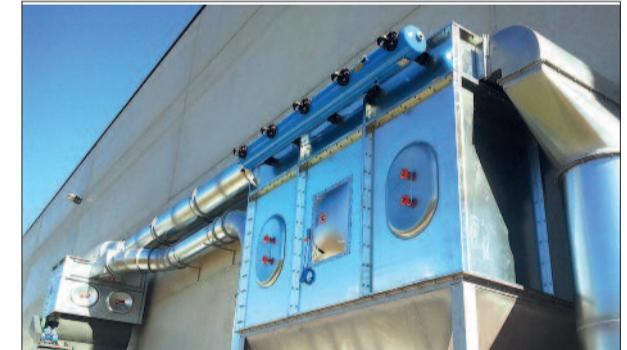
pactadora. Sistemas Gaitán realiza instalaciones de filtración de partículas de polvo que reciclan el aire para devolverlo limpio a la atmósfera.
