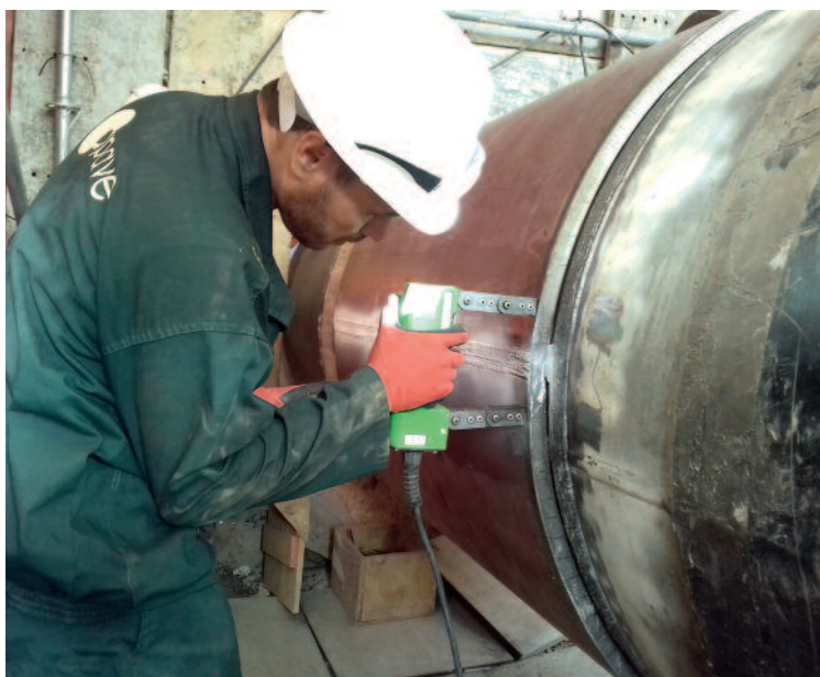
Inspección de Soldadura. Formación y Certificación impartida por Solysol
