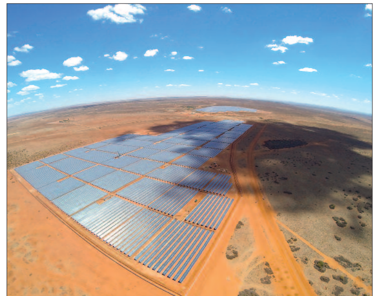
Suministro y montaje de estructura fija
