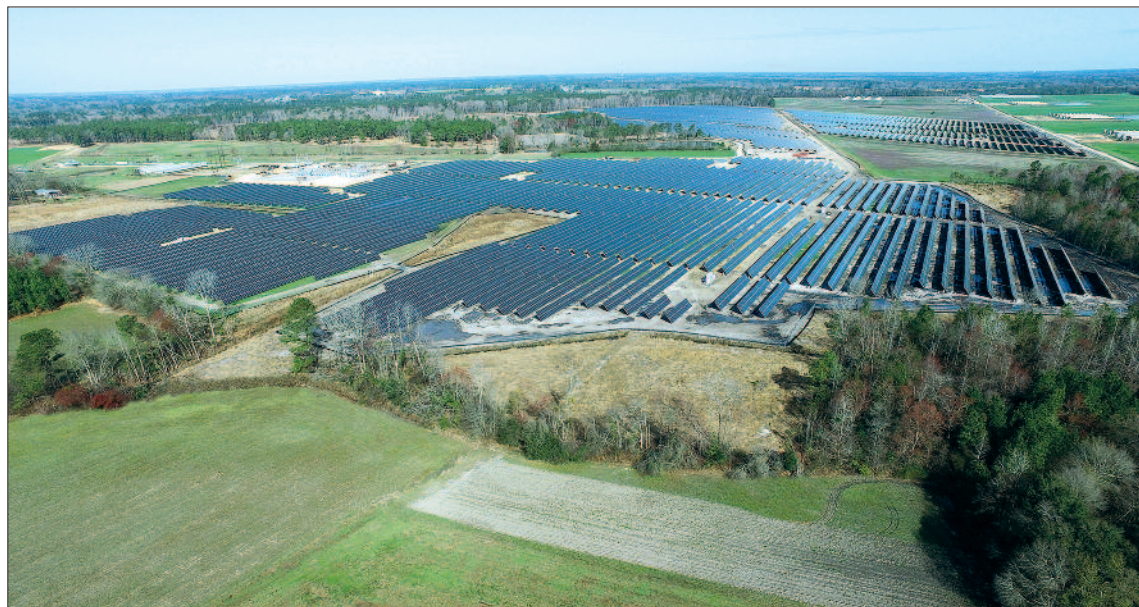
Suministro y montaje de Monoline 2V para una planta solar en Carolina del Norte
