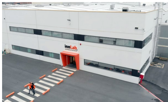
InnLab, el centro de innovación de Grupo La Plana ubicado en la planta de Onda, Castellón
