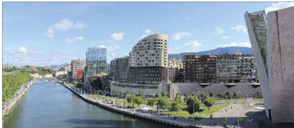
Museoalde: una vela arquitectónica con vistas al Guggenheim (viviendas y hotel).
